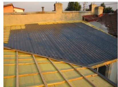
montaggio del nuovo tetto
